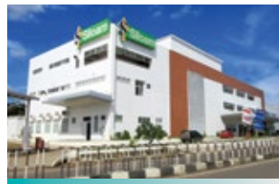
SILOAM HOSPITALS BAUBAU & LIPPO PLAZA BAUBAU
