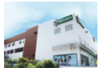
Siloam Hospitals Labuan Bajo
